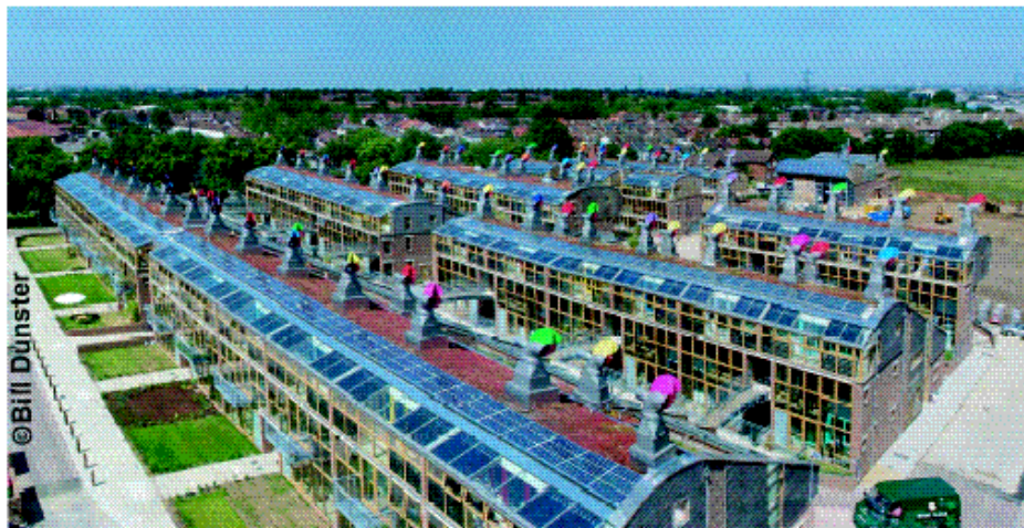
Figure 6 : BedZed, avec des murs orientés sud absorbant le soleil
