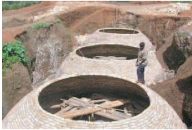
Figure 14 : usine de production de Biogaz en construction à Kigali, Rwanda - information détaillée sur www.ashdenawards.org/winners/kist05
