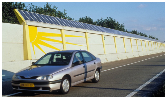
Figure 3a : élément PV intégré à une barrière sonore [réf. 5]
