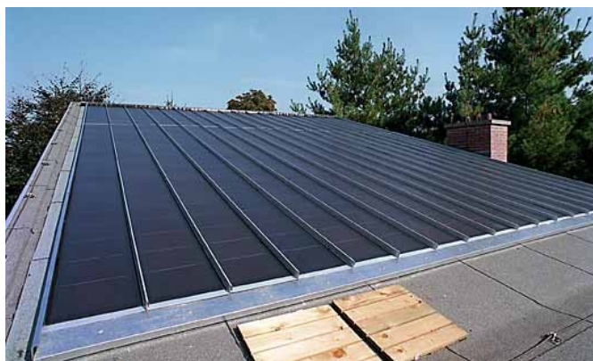
Figure 5a : modules a-si montés sur toit [réf. 5]
