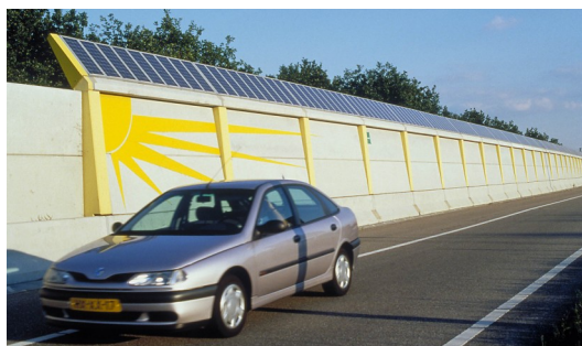
Figure 3a : élément PV intégré à une barrière sonore [réf. 5]
