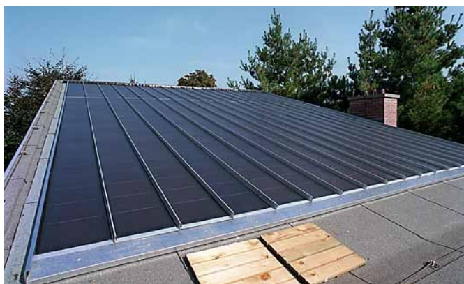
Figure 5a : modules a-si montés sur toit [réf. 5]
